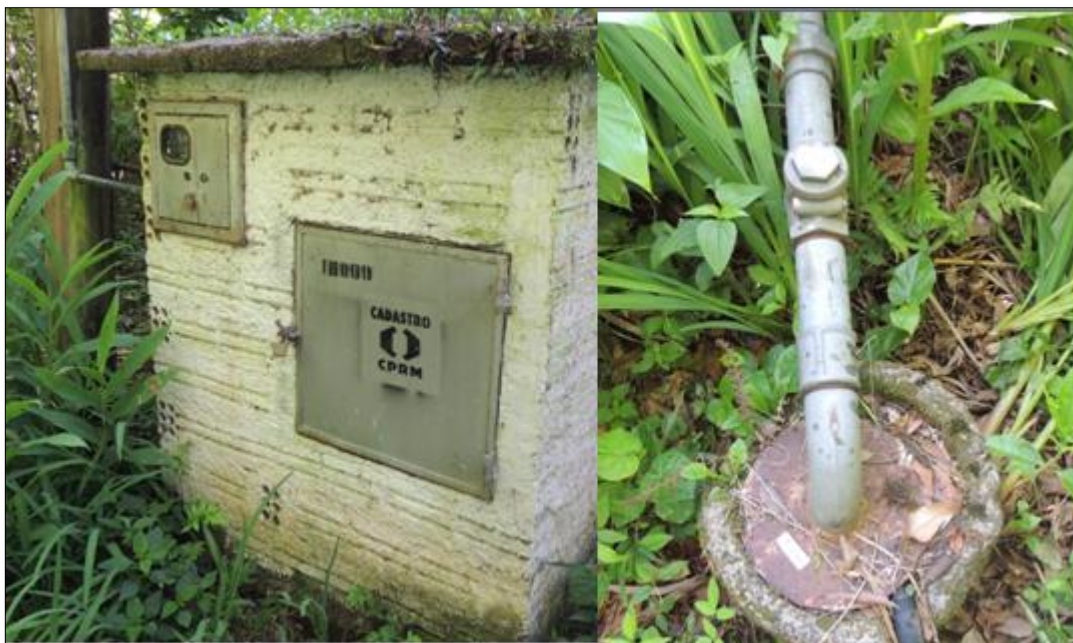
Figura 4: Poço IH099 - Linha KM 45 Fonte: Keyassociados, 2016.
