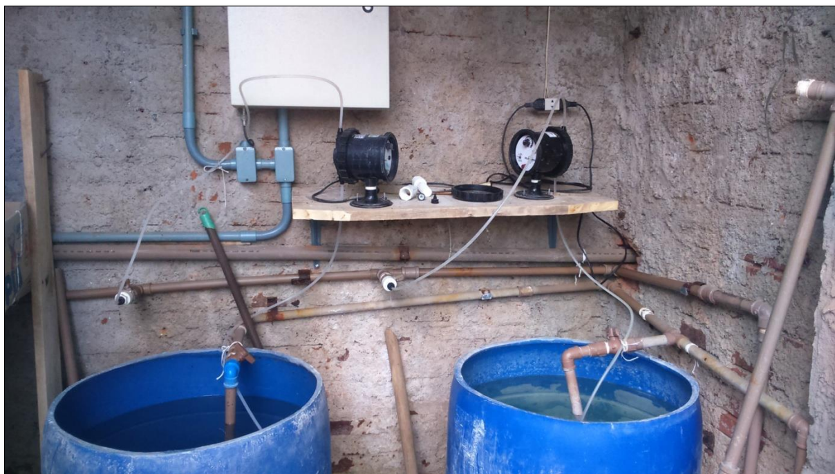
Figura 6: Sistema de Tratamento e Desinfecção. Fonte: CORSAN, 2016.
