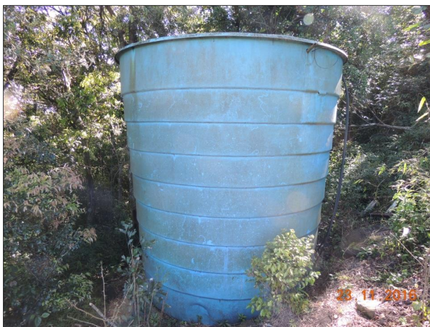
Figura 11: Reservatório 10m 3 em Fibra - PM de Riozinho Fonte: Keyassociados, 2016.
