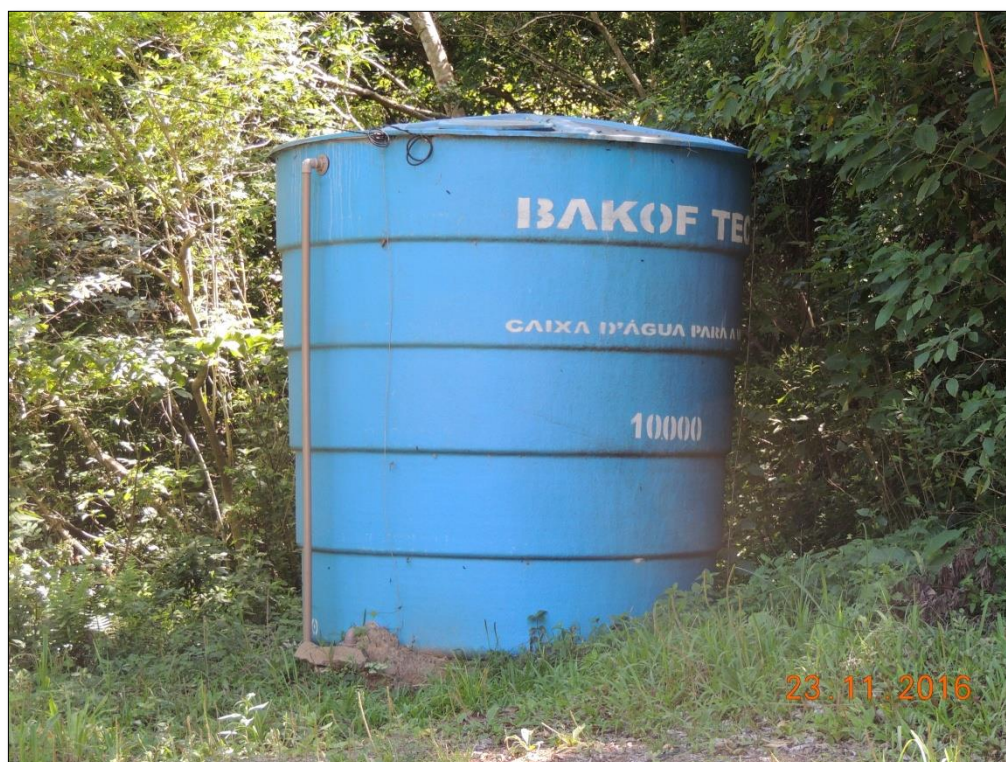
Figura 9: Reservatório de 10m³ - PM de Riozinho Fonte: Keyassociados, 2016.
